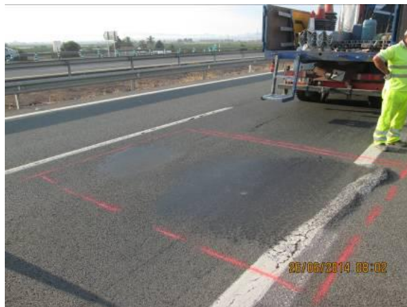
Figura 2. Marcado del deterioro
