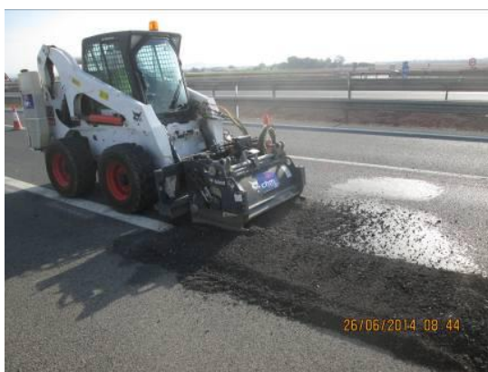
Figura 3. Excavación o fresado del pavimento bituminoso
