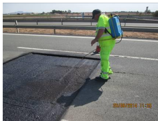
Figura 6. Riego de adherencia
